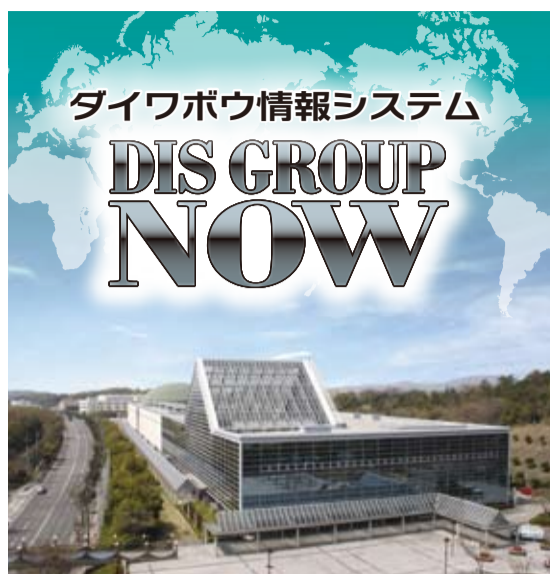
コンベックス岡山
