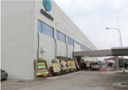
竣工した工場建屋
