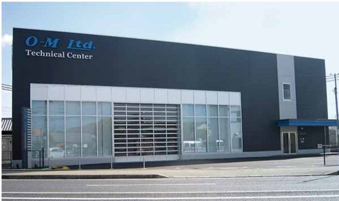
播磨テクニカルセンターの外観
