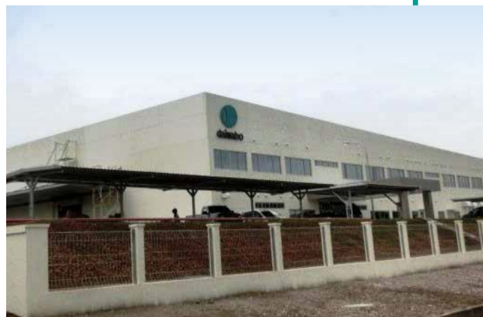
設備増強が完了したDNI
