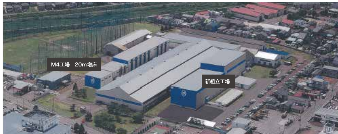
長岡工場全景
