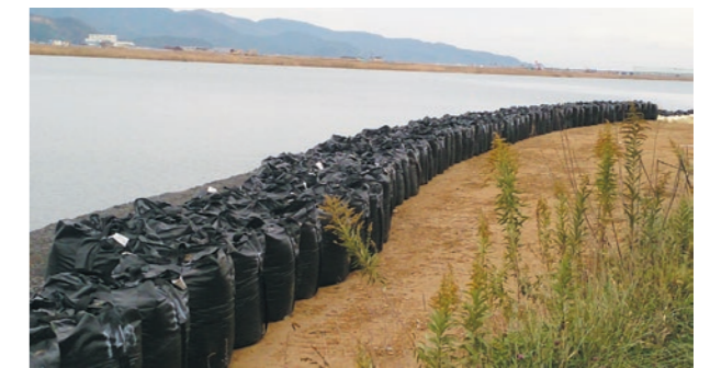
河川決壊防止 高性能大型土のう袋 カンボウプラス(株)
