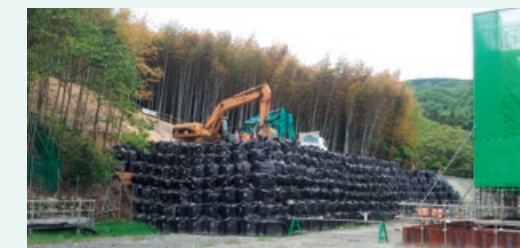
耐候性大型土のう袋「バオウ」を使用した工事の様子
